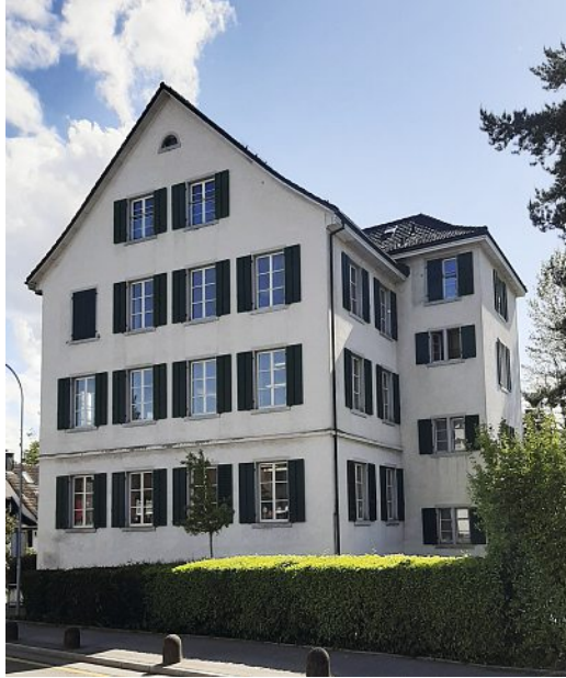
Das Schulhaus Altes Dörfli am Schulweg 2 soll eine Wärmepumpe erhalten.
