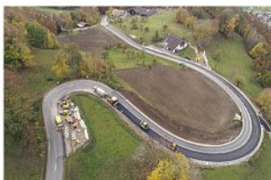
Instandsetzung Saalstrasse, Solothurn
