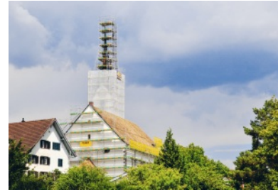
Wegen der Renovationsarbeiten eingepackt: die reformierte Kirche Hombrechtikon.
