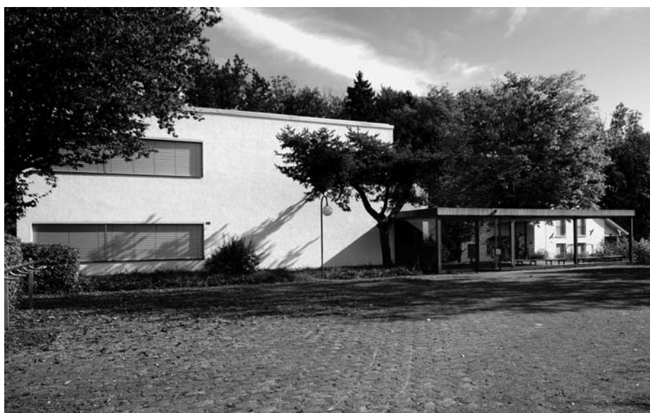
Schulhaus Tobel 1 mit Pausenplatz
