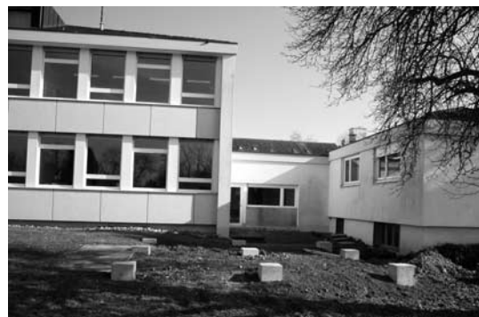
Gemeindehaus: Hier kommt der Container zu stehen.
