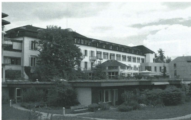
Vor Baubeginn (Frühling 2007)
