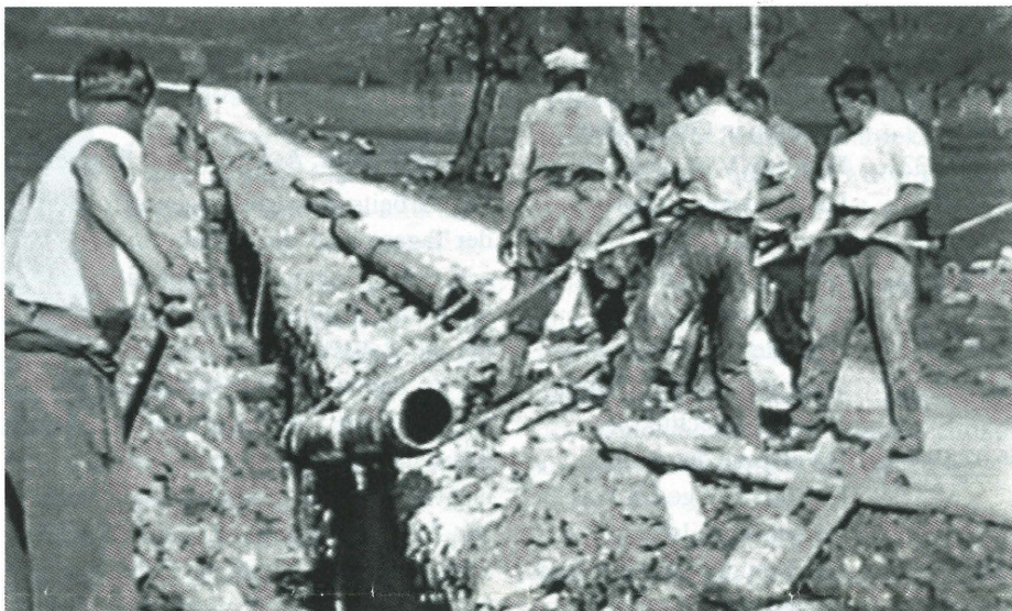
Rohrlegung Transportleitung – Absenken der schweren Gussrohre.
