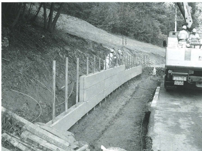
Montage der Stützmaurelemente «System Ribbert» entlang des Rutschgebietes «Hangried»
