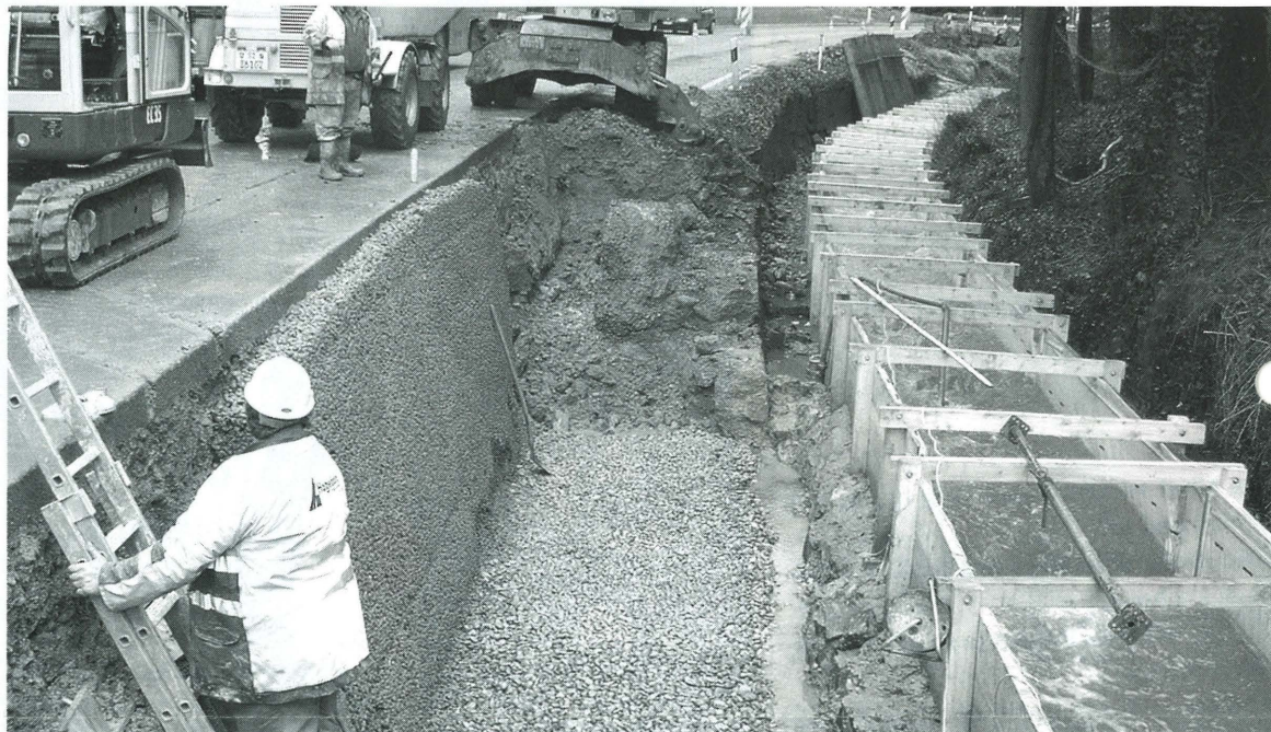
Baugrube und provisorische «Umleitung» des Feldbaches für den Neubau der Ufermauern
