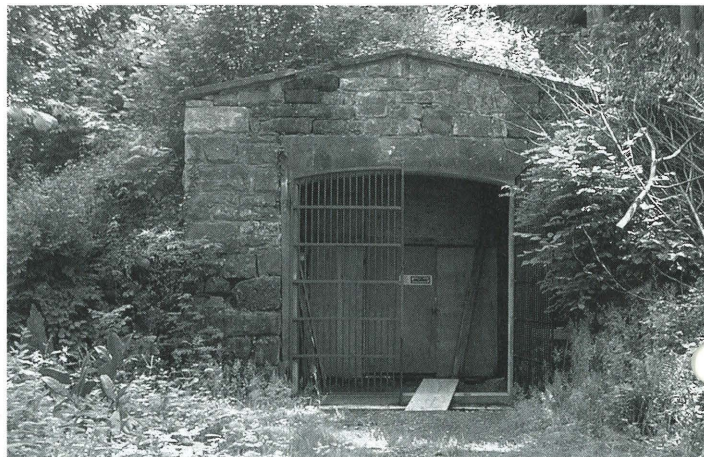
Der Eingang zum ehemaligen Bierkeller der Brauerei Hürlimann in Feldbach.
