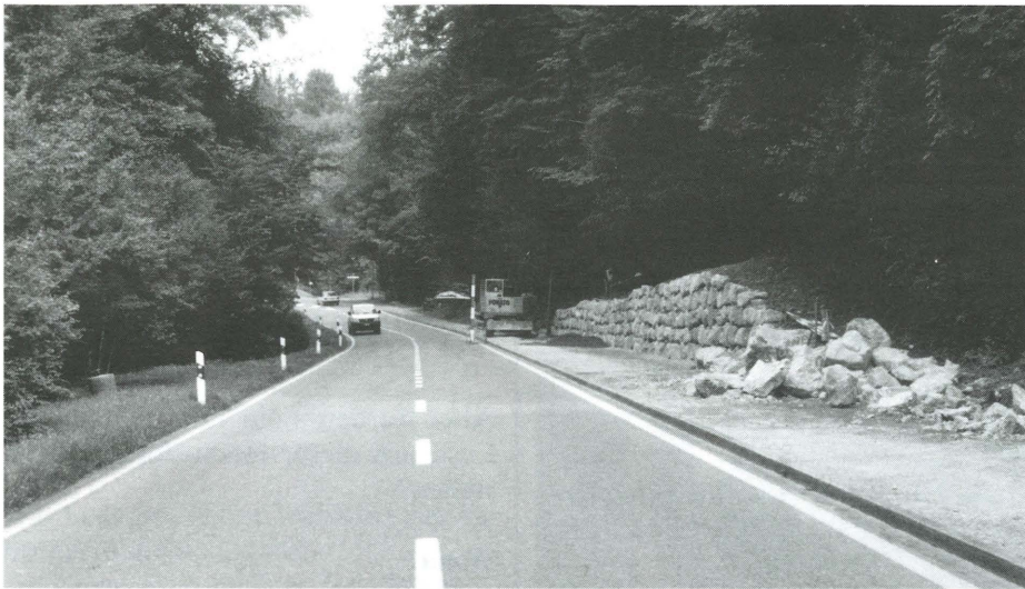
Der neue, kombinierte Rad-/Gehweg hat eine durchgehende Breite von 3.00 m und ist zur Erhöhung der Sicherheit und Verbesserung der optischen Gestaltung von der Fahrbahn mit einem 1.00 m breiten Grünstreifen getrennt.
