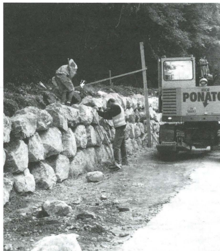
Auf rund 70 m Länge ist eine Stützmauer notwendig, welche mit formwildem Naturstein aus Alpenkalk ausgeführt wird.
