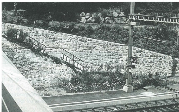
Der Treppenabgang von der Rütigasse auf den Perron Nord
