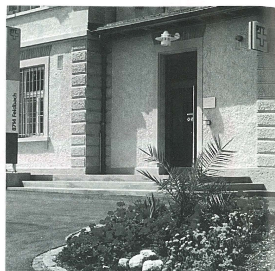
Der Eingang zur neuen Post
