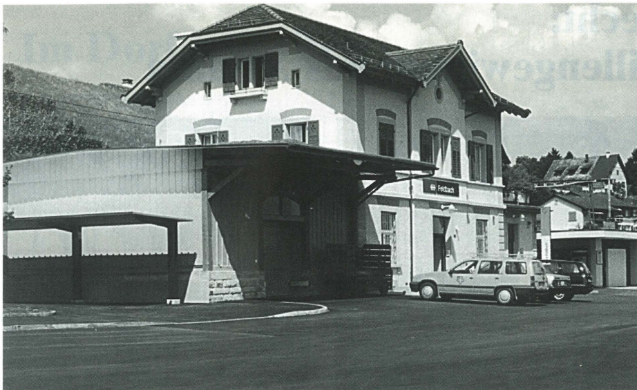
Das umgebaute Aufnahmegebäude: Vor dem Schuppen, welcher ebenfalls von der Post genutzt wird, die überdachten Veloabstellplätze
