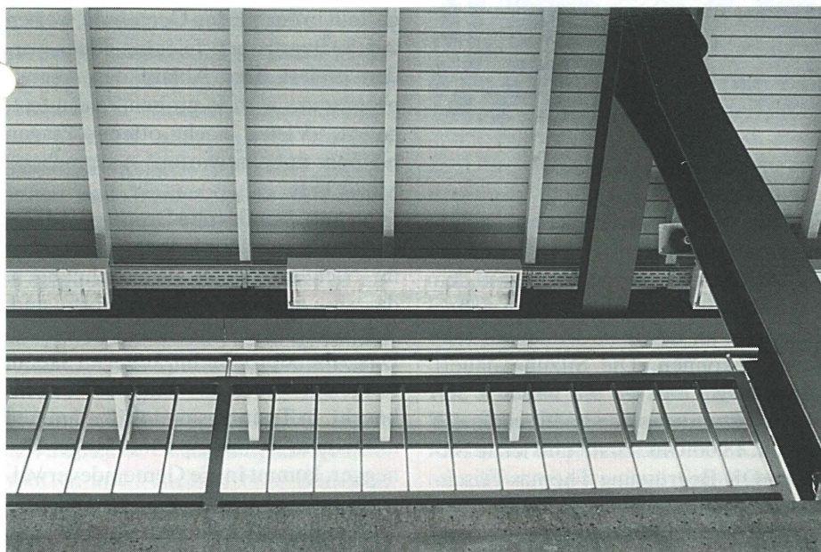
Ein Blick aus der Personenunterführung nach oben: Perrondach mit Stütze und Geländer
