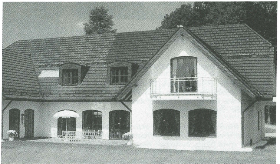
Landhaus mit Solarzellen zur Stromerzeugung, die in die Ziegel integriert sind
