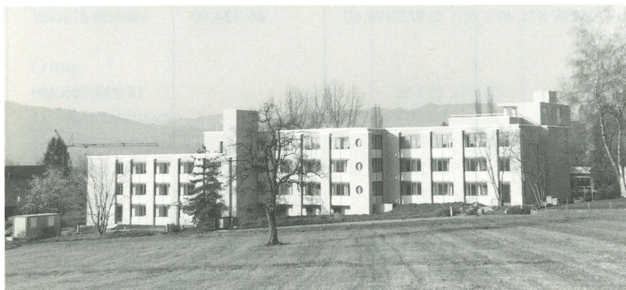
Die renovierte Alterssiedlung Breitlen
