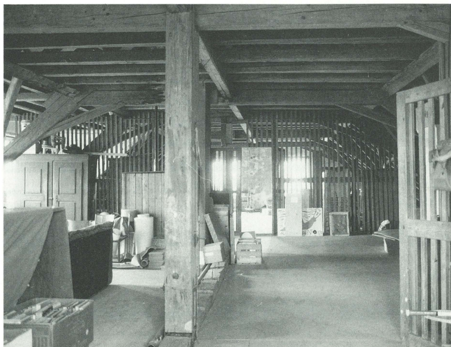
Der Estrich im Schulhaus «altes Dörfli»: Hier soll der Lehrerbereich und ein disponibler Raum entstehen.
