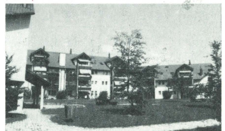
Das Bild vom «Bärdörfli» steht für die grossen Überbauungen im Dörfli, Holzflüe, Lüeholz und Tobel
