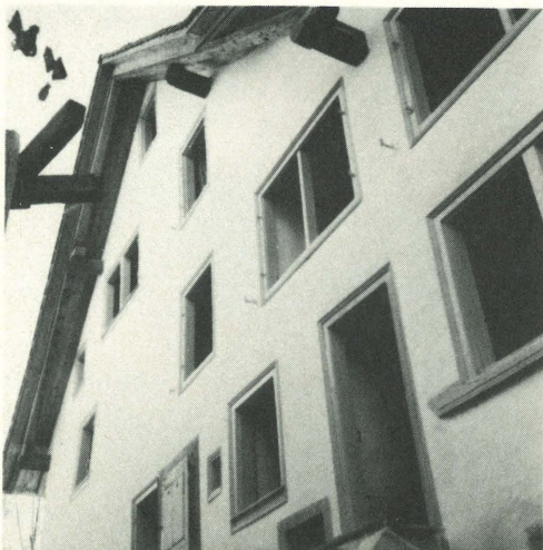
Die Ostfassade im neuen Glanz! Inzwischen sind auch die Fenster angebracht. (Aufnahme vom 15. November 1987).
