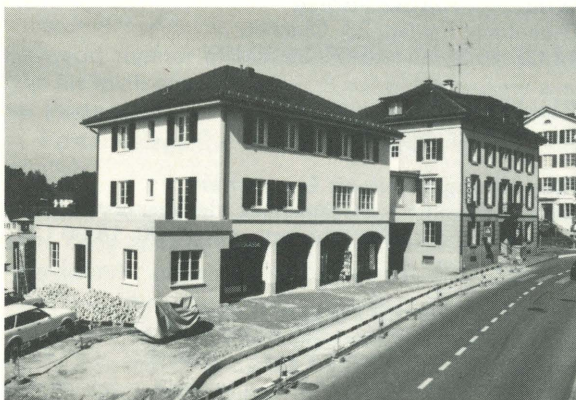
Blick auf Kronenanbau mit Bushaltestelle kurz vor der Fertigstellung
