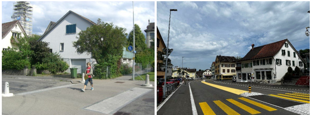
Abbildung 13: Querungshilfen vertikaler Versatz in Oberrieden (links) und Schutzinsel mit Fussgängerstreifen in Hinwil (rechts)
