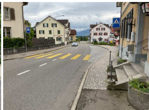
Abbildung 49: Mangelhafte punktuelle Querungsmöglichkeit (Kronenkreuzung) (Metron, 2023)
