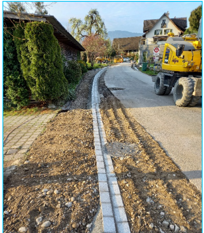
Randsteinsanierungen beim Garstligweg, Rickenstrasse, Eichwisrain, Eichtalstrasse und Breitacherstrasse (770 m)
